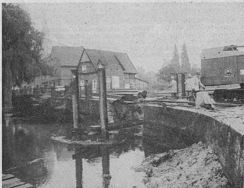
Die Hessel mußte begradigt werden, die kurvige Hauptstraße mußte ausgebaut werden.
