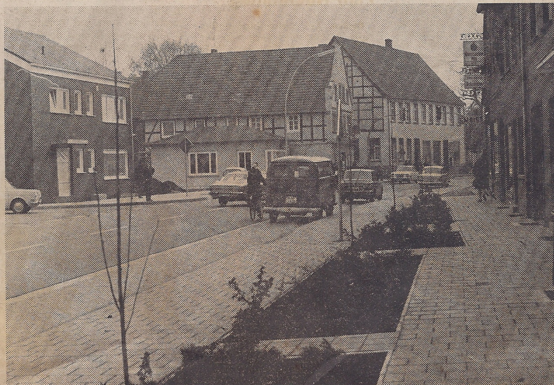
Zügig läuft jetzt der Verkehr über die Von-Galen-Straße, die Ortsdurchfahrt im Zuge der B 475. Die Straße ist verbreitert, Parkspuren sind angelegt, vor den Bürgersteigen noch Pflanzstreifen geschaffen worden.
